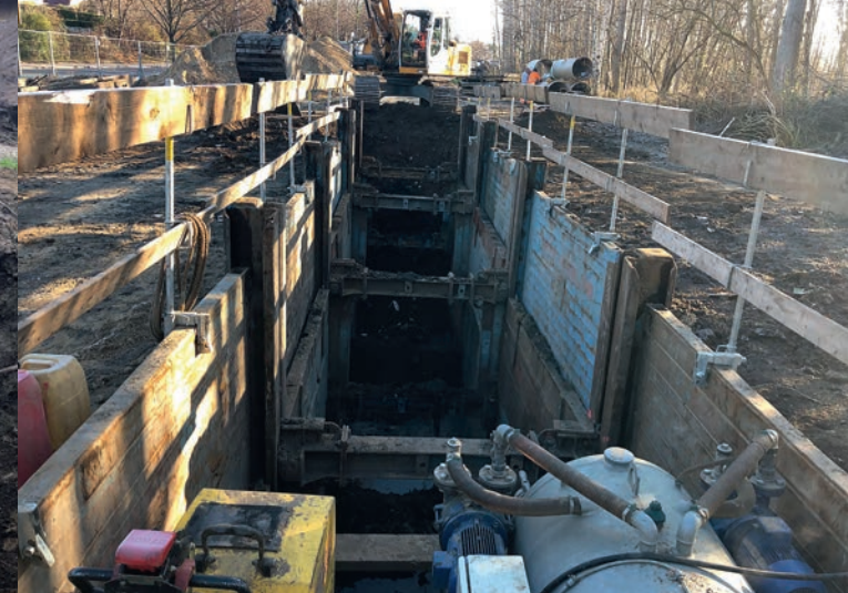
Zum Teil war die Baugrube 7,5 m tief.
