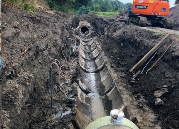
Die neuen Rohre wurden teilweise im ursprünglichen Kanal verlegt.
