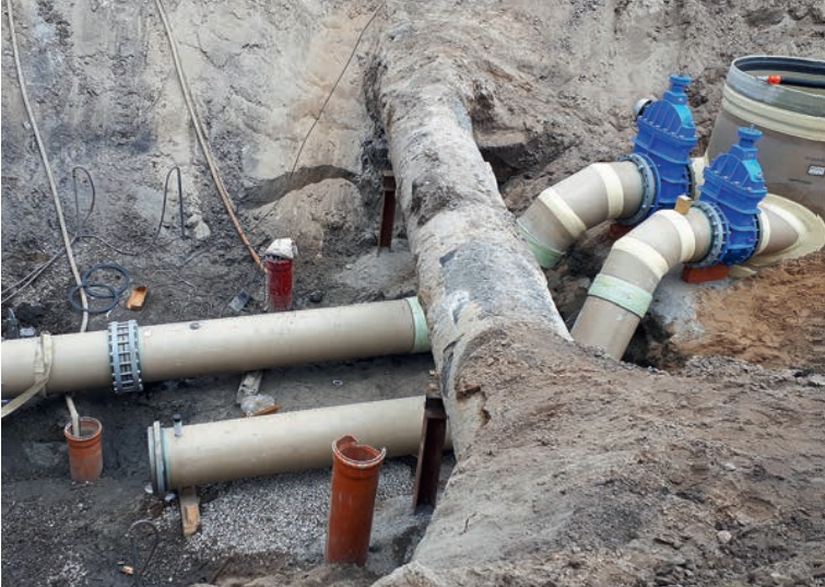
Modernes GFK-Rohr kommt zum Einsatz.
