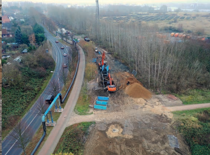
Überpumpanlage im Ortsteil Dierkow
